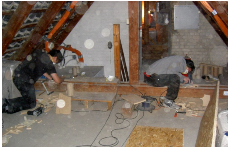
Neulich oben unterm Dach: Schüler der STS Barmbek bei der Dämmung der obersten Geschossdecke
